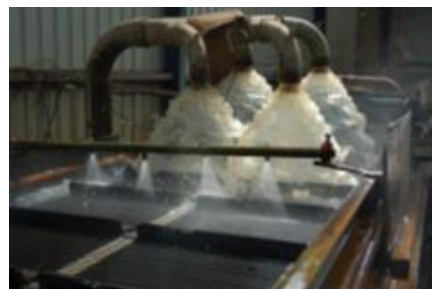
Spoelinstallatie waarmee met weinig water wordt nagespoeld (de vier kleine spuitdoppen). Foto: Arie Dwarswaard, Bloembollensvisie.
